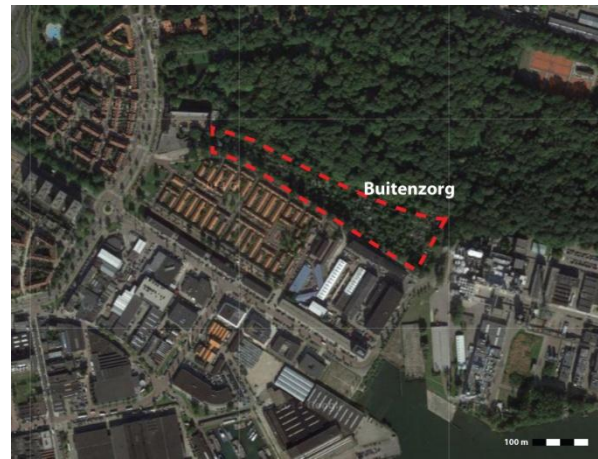
Figuur 41 Luchtfoto Buitenzorg (Google.nl/maps)
